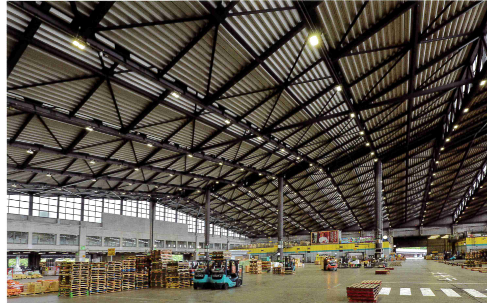
青果棟の1階フロアから更新したLED高天井器具を望む①
